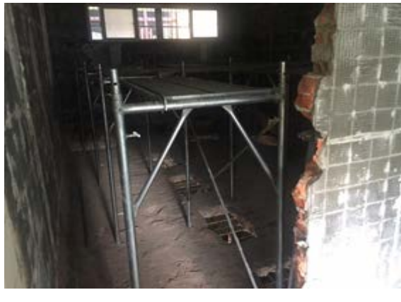
和平樓廁所施工情形（二）
