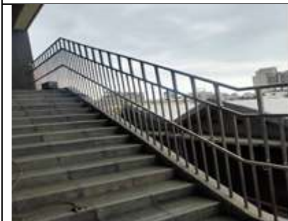
悅學樓樓梯 4-5F 白鐵欄杆加高
