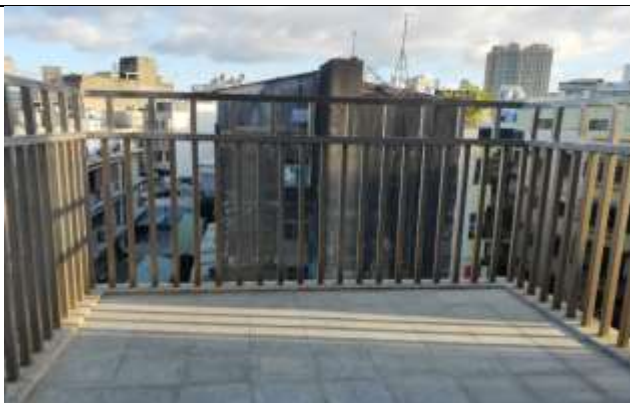
悅學樓安全防護加高護欄
