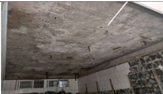
和平樓廁所 RC 天花板鋼筋除鏽並以天花板重新整理
