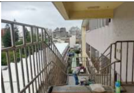
悅學樓樓梯 4-5F 白鐵欄杆加高
