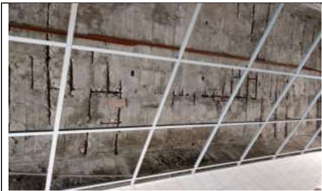
和平樓廁所 RC 天花板鋼筋除鏽前天花板鋼筋鏽蝕裸露
