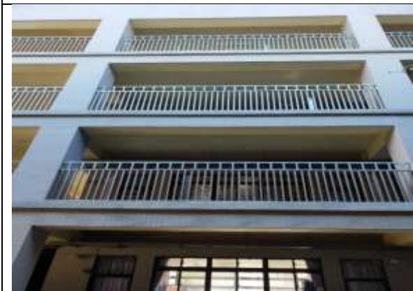
悅學樓安全防護加高護欄
